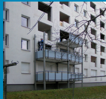
Demontage von Balkontüren und Fenstern zur Wiederverwendung
