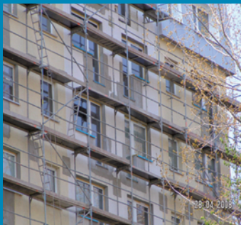
Wiederherstellung des Wärmedämmverbundsystems nach Balkontürmontage
