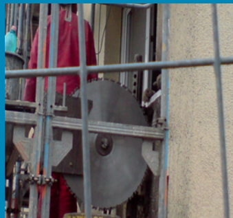
Betonschneidearbeiten mit Diamantschneidetechnik im Brüstungsbereich
