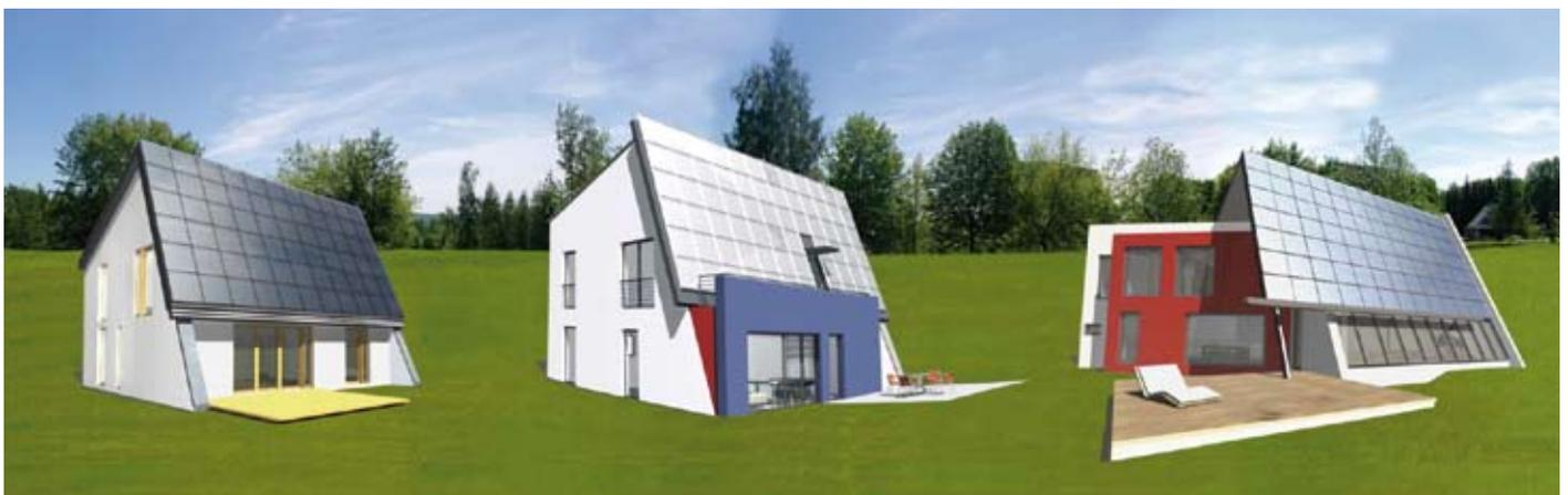
architektur, großflächiger thermischer Solaranlage, zentralem Langzeitwärmespeicher, massiven und ökologischen Baustoffen zur Wärmedämmung werden nahezu 100 % des Wärmebedarfs für Heizung und Warmwasser des Gebäudes durch Sonnenenergie gedeckt.
